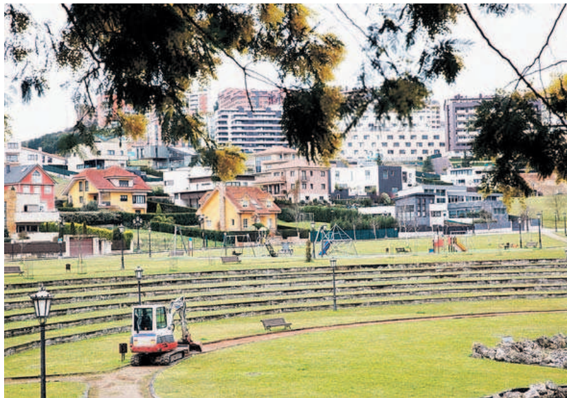
Inicio de las obras en el parque de Montecerrao, ayer, a media mañana. | MIKI LÓPEZ
